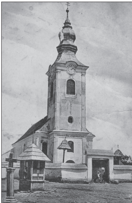
4. kép. A szentegyházásfalui római katolikus templom (1930)
