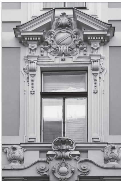
6. kép. A Szentegyház utca felőli homlokzatrészlet
