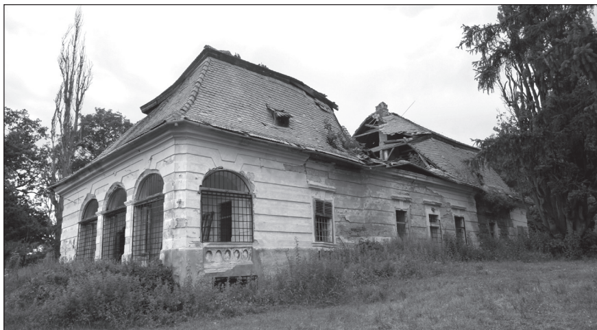
4. kép. Az udvari homlokzat a déli árkádos előtérrel
