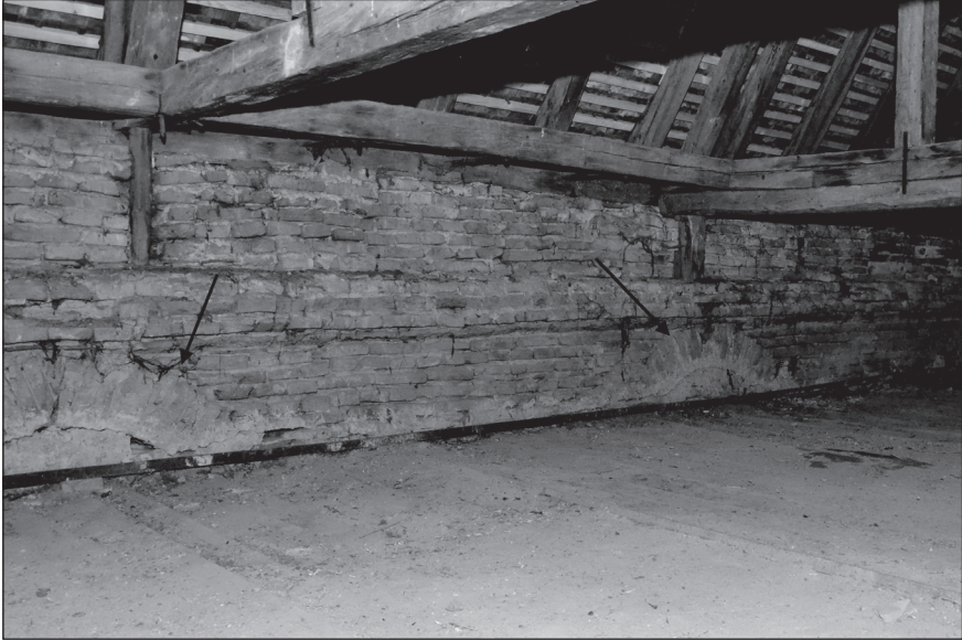
4. kép. Befalazott, ovális ablakok nyomai a tetőtérben
