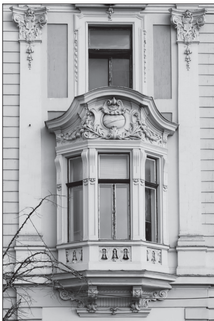
5. kép. Főtér felőli homlokzatrészlet
